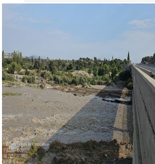
FOTO N°02: Vista en la que se aprecia la carencia de diques secos con acumulacion de material propio en ambas margenes del río.
